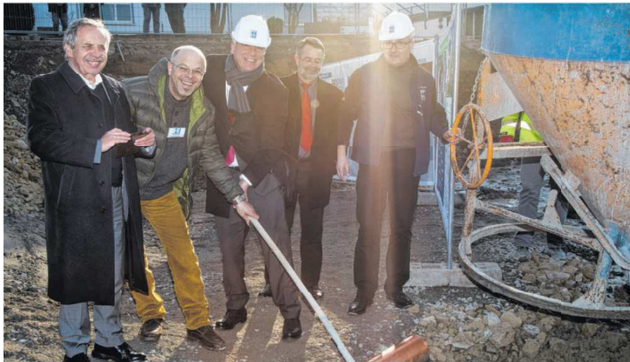
Bei der Grundsteinlegung für das Enzpark-Quartier waren Bernd Raff, Sven Heuschele, Oberbürgermeister Jürgen Kessing, Ralf Oldendorf und Horst Köhler dabei (von links). Foto: Helmut Pangerl
